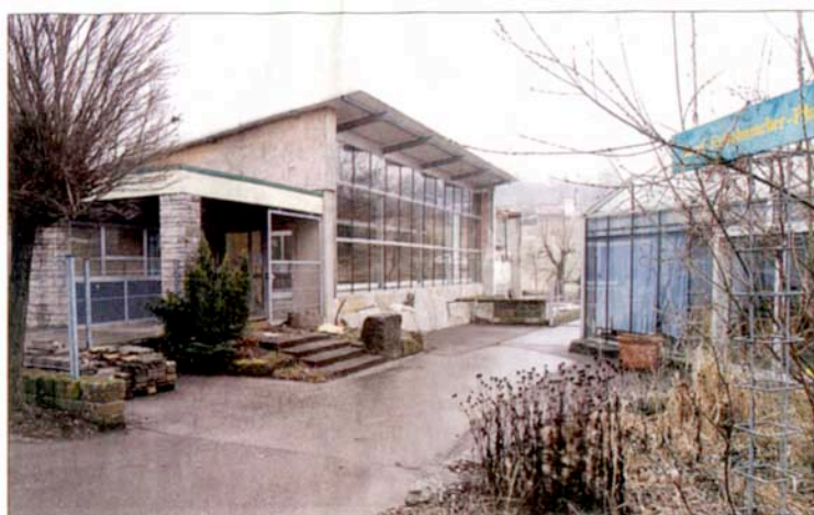
Das Bürogebäude mit Ausstellungsraum (links) im ehemaligen Gartencenter Schmid wird zum neuen Domizil des Maschinerrings Ostalb umgebaut. Rechts ein verglaster ehemaliger Ausstellungs- und Verkaufsraum, der zunächst mal als Lagerfläche genutzt werden soll. (Foto: opo)
